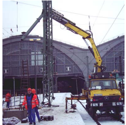
Unimog U1650 mit Pk 17000 u.a. für Oberleitungsarbeiten
