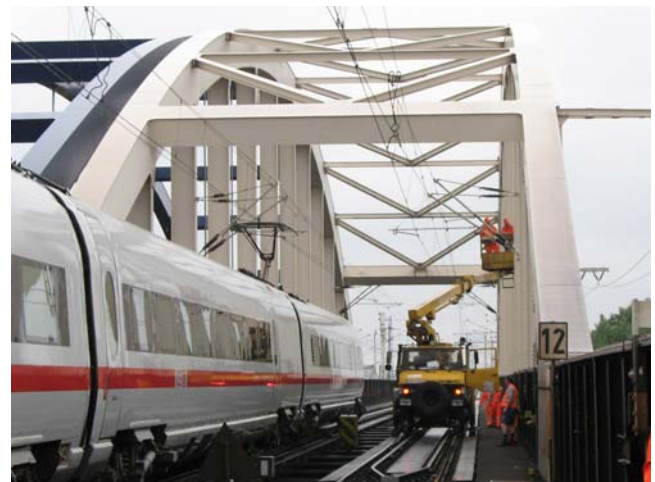
BV Riesa (Brückenprüfung)
