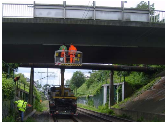
BV Schwerin (Brückenprüfung)
