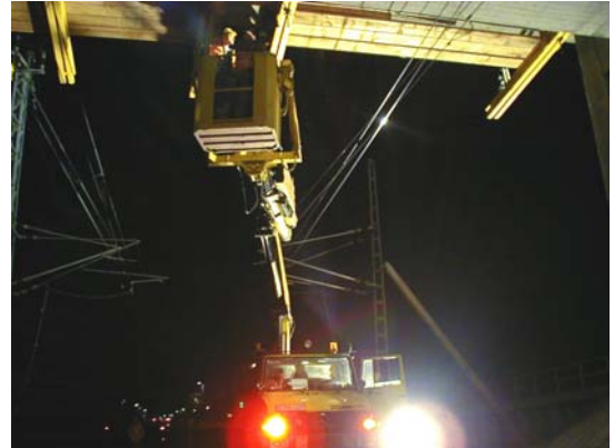
BV Berlin (Demontage Schalung u.ä.)
