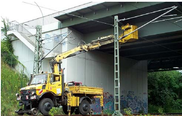
BV Berlin (Brückenprüfung)
