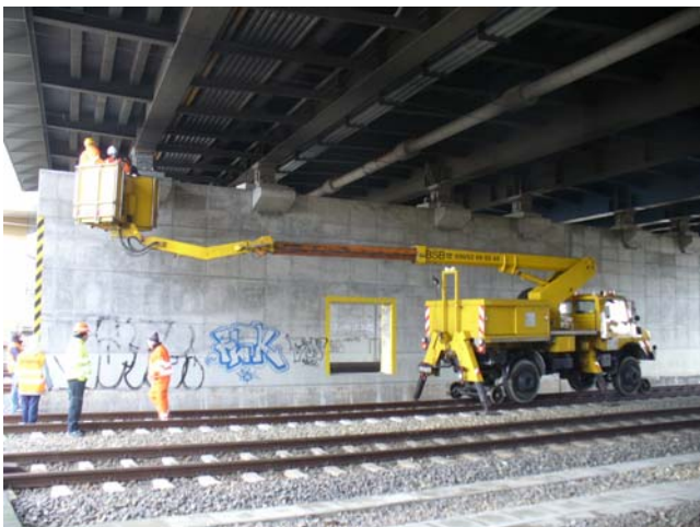
BV Berlin; Beusselbrücke (Brückenprüfung)
