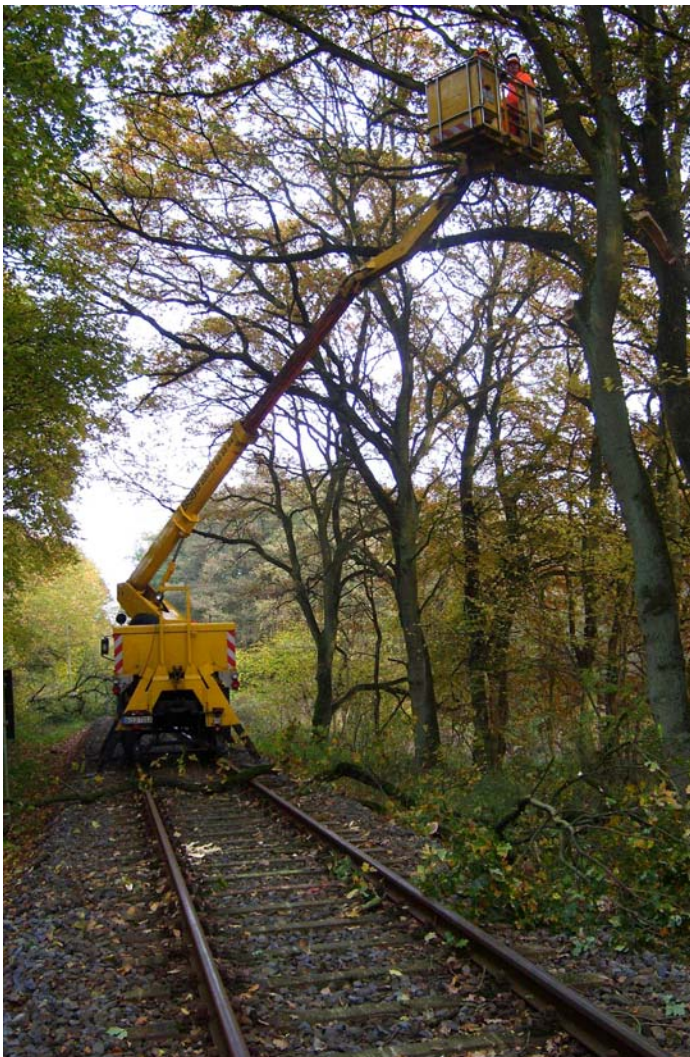
Profilfreischnitt mit Hubarbeitsbühne
