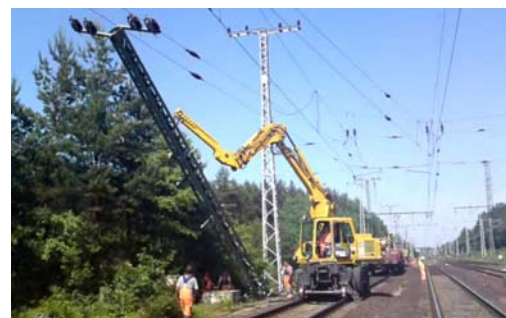
Montage/Demontage von Masten mit Armverlängerung
