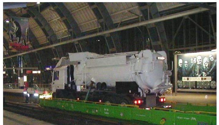
Vacu (Hi-Lift) im Gleis
