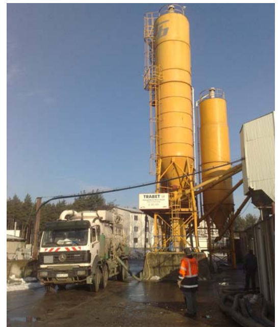
Siloberäumung (Zement)
