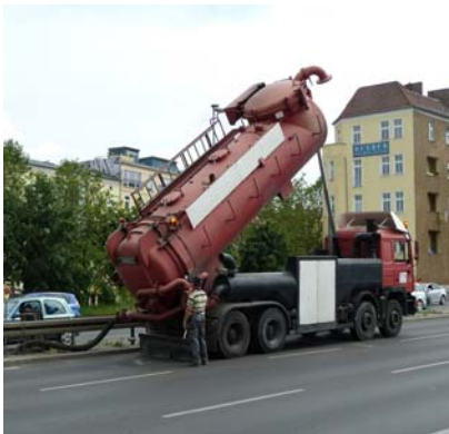
Einblasen Sand in Brückenfundament
